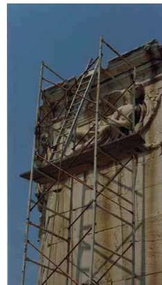
La face Sud-Ouest
