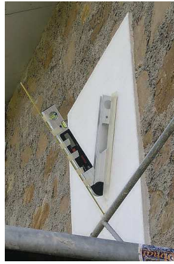
Maintien du style en position durant la prise du scellement
