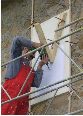
Perçage du logement du style
